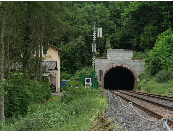
Michelsberg-Tunnel und Streckenwärterhaus bei Weilburg-Kirschhofen (2017) Fotograf/Urheber: Jörn Schultheiß
