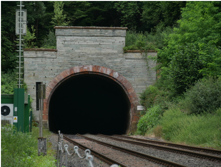
Südportal des Michelsberg-Tunnels bei Weilburg-Kirschhofen (2017) Fotograf/Urheber: Jörn Schultheiß
