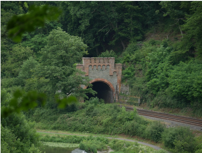
Südportal des Kirschhofener Tunnels bei Weilburg-Kirschhofen (2017) Fotograf/Urheber: Jörn Schultheiß
