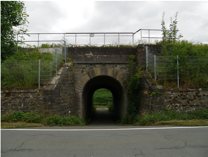
Östlicher Eingang der südlichen Unterführung zwischen der Weilstraße und der Uferstraße bei Weilburg (2017) Fotograf/Urheber: Jörn Schultheiß
