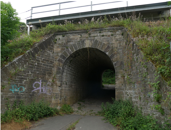
Westlicher Eingang der nördlichen Unterführung zwischen der Weilstraße und der Uferstraße bei Weilburg (2017) Fotograf/Urheber: Jörn Schultheiß
