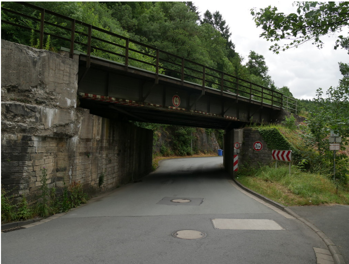
Eisenbahnbrücke über die Weilstraße in Weilburg, Blick Richtung Südosten (2017) Fotograf/Urheber: Jörn Schultheiß
