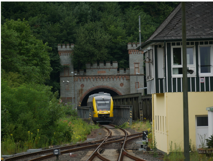
In den Bahnhof Weilburg einfahrender Zug auf der Eisenbahnbrücke nach dem Weilburger Tunnel (2017) Fotograf/Urheber: Jörn Schultheiß
