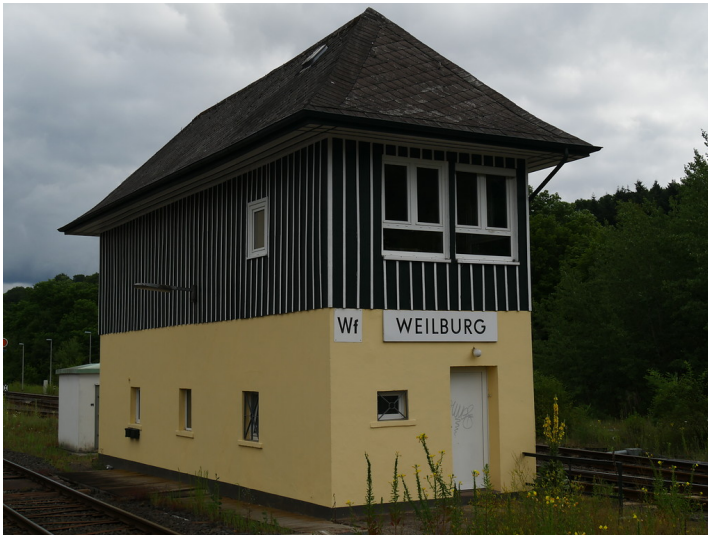
Stellwerksgebäude Wf des Bahnhofs Weilburg (2017) Fotograf/Urheber: Jörn Schultheiß
