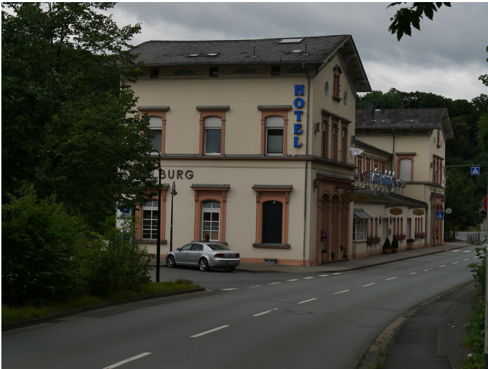
Seitenansicht des Hauptgebäudes des Bahnhofs Weilburg (2017) Fotograf/Urheber: Jörn Schultheiß
