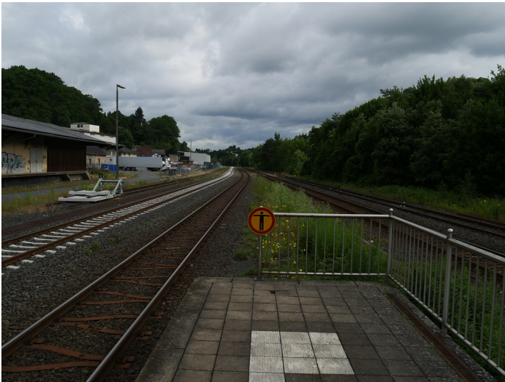
Bahnsteig sowie links im Bild der Schuppen des Güterbahnhofs auf dem Bahnhofsgelände Weilburg (2017) Fotograf/Urheber: Jörn Schultheiß
