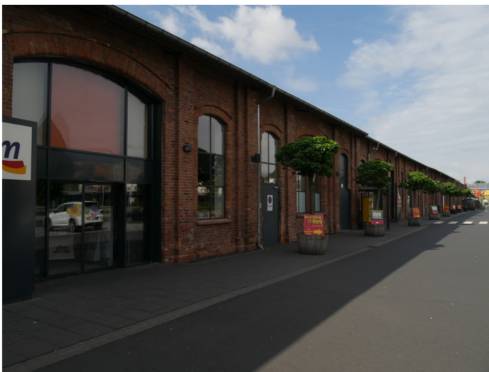
Nördliche Außenfassade der ehemaligen Richehalle des Bahnausbesserungswerkes Limburg (2017) Fotograf/Urheber: Jörn Schultheiß
