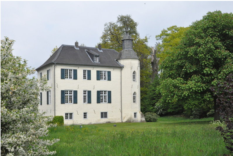
Haus Bey mit Turm (2017) Fotograf/Urheber: Nicole Schmitz
