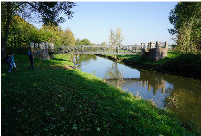
Brücke in der Trasse der Geldernschen Kreisbahn über die Niers bei Wachtendonk (2017) Fotograf/Urheber: Claus Weber
