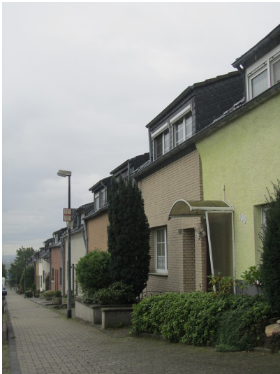
Reihenhäuser der Kolonie Pingsdorf im oberen Teil der Maiglerstraße (2014) Fotograf/Urheber: Nicole Schmitz
