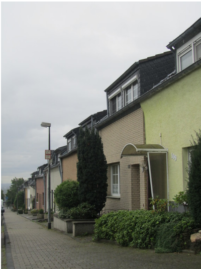
Reihenhäuser der Kolonie Pingsdorf im oberen Teil der Maiglerstraße (2014) Fotograf/Urheber: Nicole Schmitz
