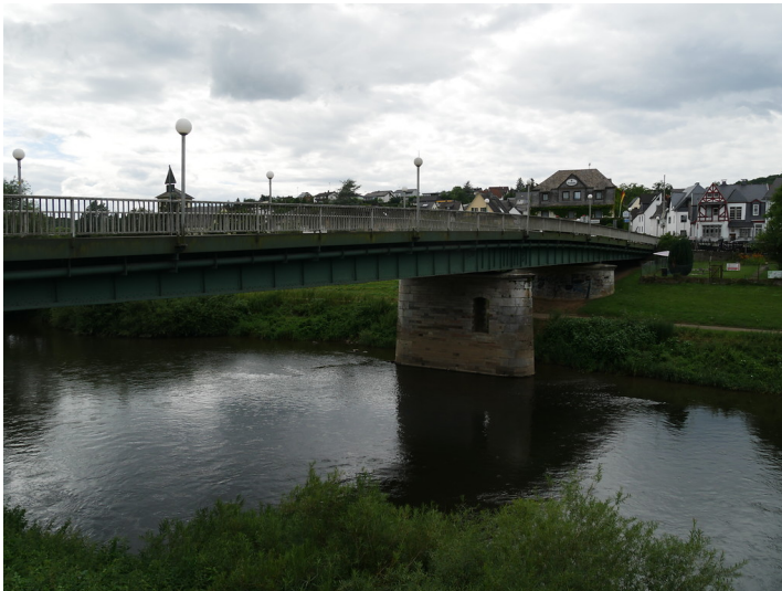
Straßenbrücke in Villmar-Aumenau, Blick von der linken Lahnseite Richtung Nordwesten (2017) Fotograf/Urheber: Jörn Schultheiß
