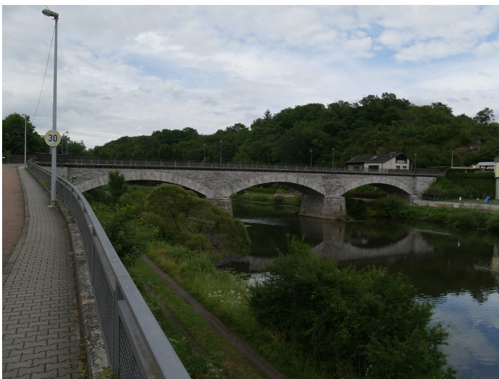
Südansicht der Marmorbrücke in Villmar (2017) Fotograf/Urheber: Jörn Schultheiß
