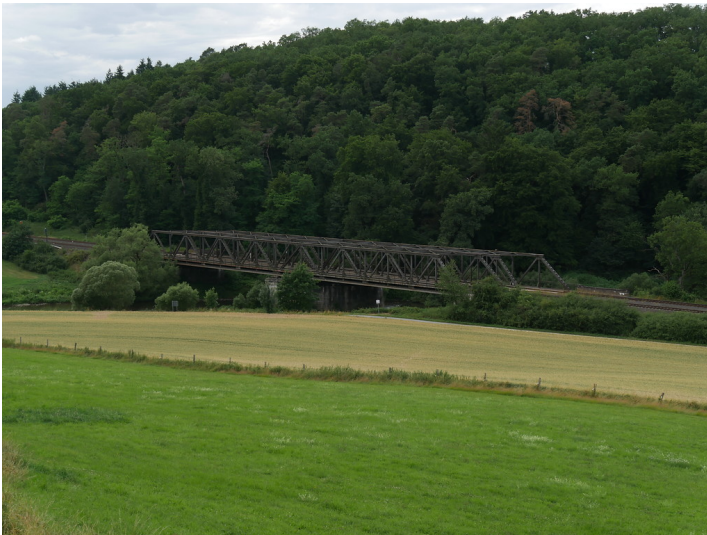
Nordansicht der Eisenbahnbrücke zwischen Villmar-Aumenau und Runkel-Arfurt (2017) Fotograf/Urheber: Jörn Schultheiß
