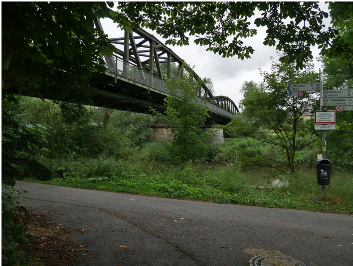
Ostansicht der Eisenbahnbrücke bei Limburg-Staffel (2017) Fotograf/Urheber: Jörn Schultheiß
