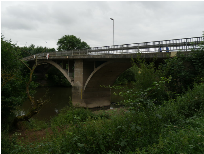
Nordansicht der Straßenbrücke bei Limburg-Staffel (2017) Fotograf/Urheber: Jörn Schultheiß
