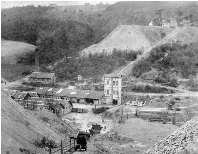
Die Grube Berzelius um 1880. Zu sehen sind das Betriebsgelände mit Werkstätten, die Aufbereitungsanlage und das Zechenhaus im Volbachtal; rechts oben befindet sich die Schachanlage mit Fördermaschinenhaus, Halden und Schrägförderung. Fotograf/Urheber: unbekannt; Alexander Kierdorf
