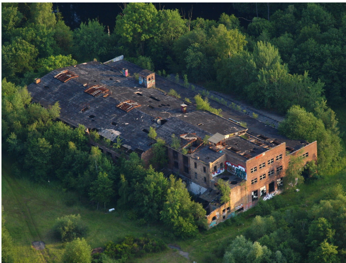
Luftaufnahme des Pleistalwerks bei Sankt Augustin-Niederpleis (2011).
