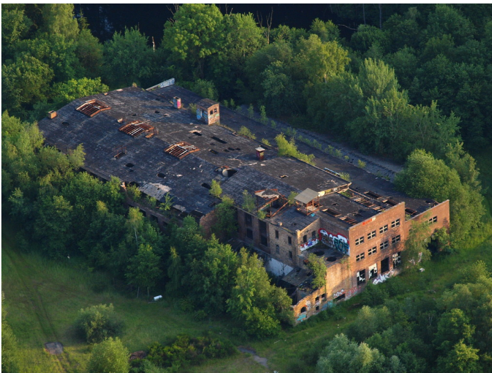
Luftaufnahme des Pleistalwerks bei Sankt Augustin-Niederpleis (2011).
