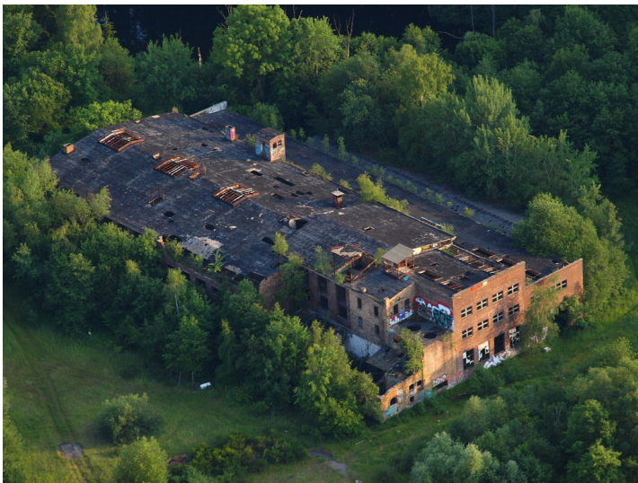
Luftaufnahme des Pleistalwerks bei Sankt Augustin-Niederpleis (2011).
