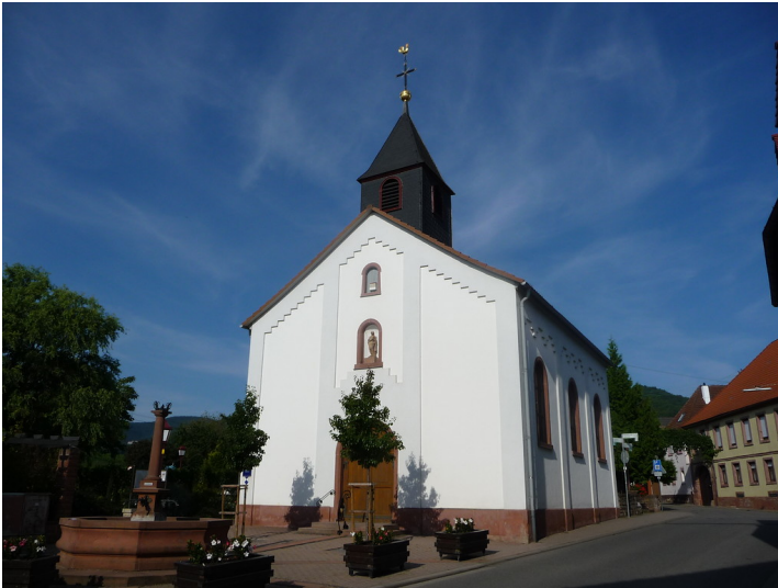
Die Alsterweiler Kapelle im gleichnamigen Ortsteil von Maikammer (2010) Fotograf/Urheber: Immanuel Giel
