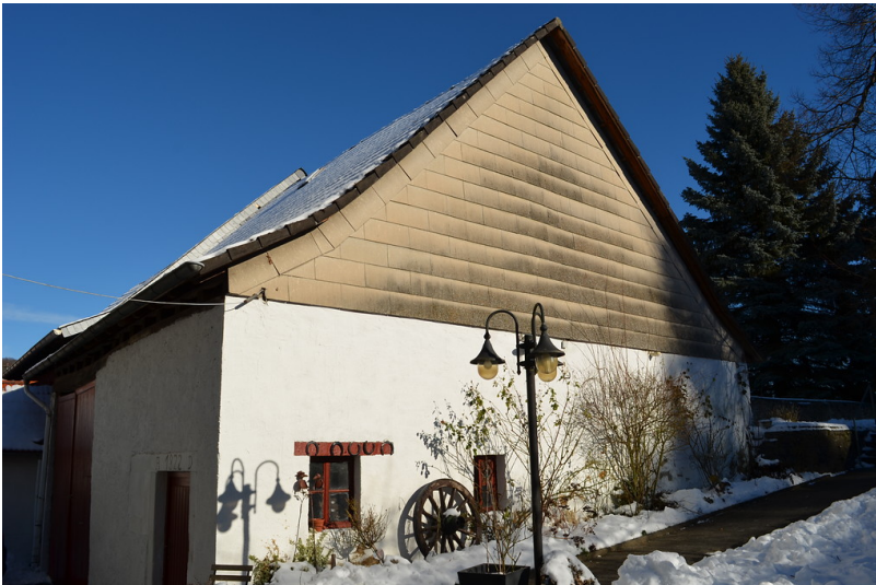
Seitenansicht der Scheune gegenüber des alten evangelischen Pfarrhauses Seibersbach, Blickrichtung Norden (2017) Fotograf/Urheber: Magnus Lickfett
