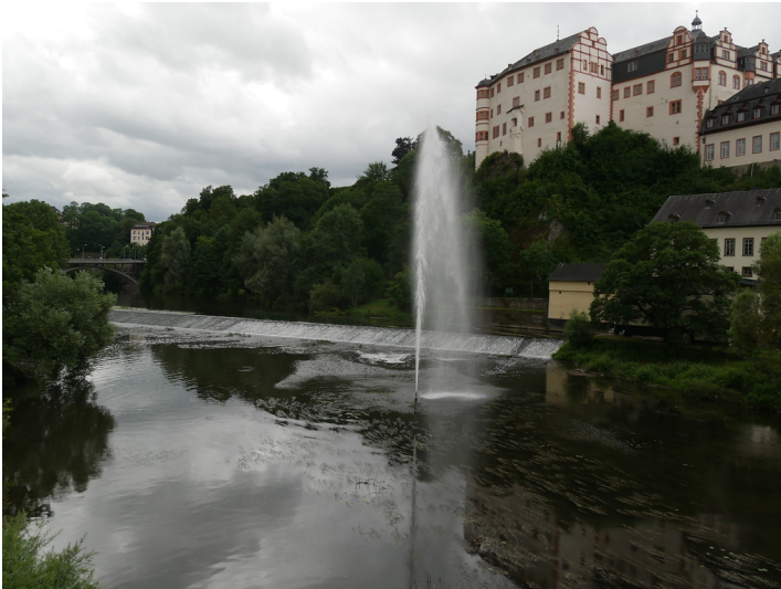
Brückenmühle und zugehöriges Wehr in Weilburg (2017) Fotograf/Urheber: Jörn Schultheiß
