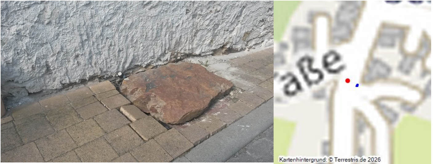
Abdeckung des alten Brunnens in der Dörrebacher Straße gegenüber der evangelischen Kirche Seibersbach (2017) Fotograf/Urheber: Naomi Straub
