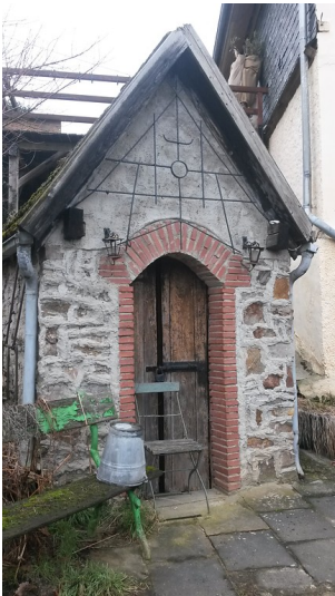
Brunnenhaus auf dem Füllenbacher Hof bei Seibersbach (2017) Fotograf/Urheber: Naomi Straub
