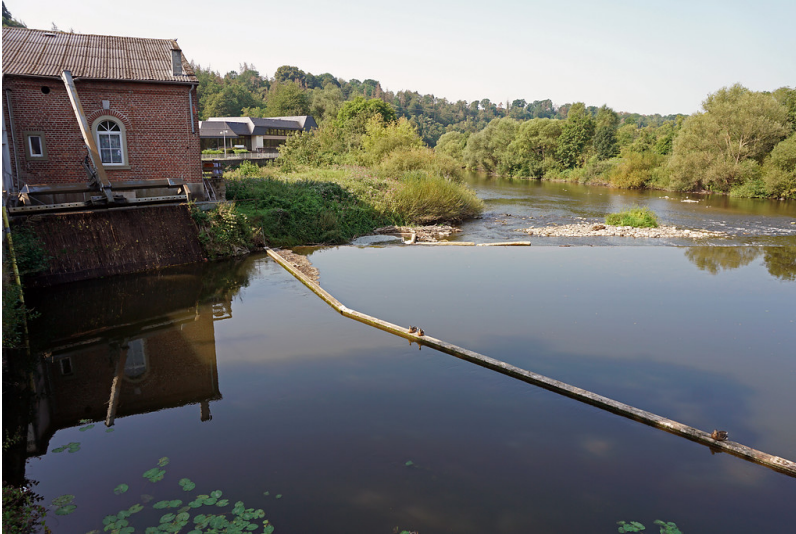
Turbinenhaus am Villmarer Lahn-Marmor-Weg; Rundweg 1 (2019) Fotograf/Urheber: Karl Peter Wiemer
