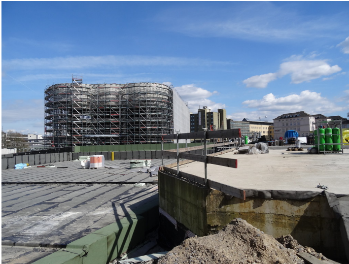
Baustelle Döppersberg im März 2017 Fotograf/Urheber: Sabrina, Ranke
