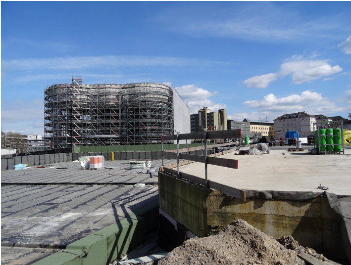
Baustelle Döppersberg im März 2017 Fotograf/Urheber: Sabrina, Ranke
