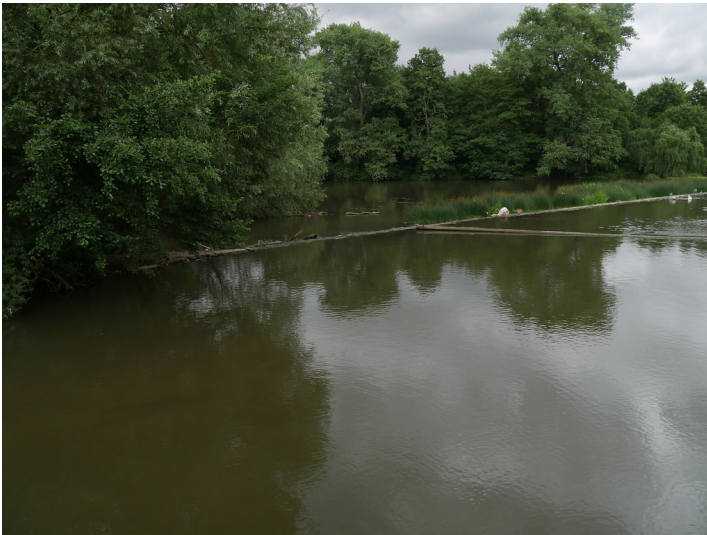
Südansicht des Wehrs der Obermühle Limburg (2017) Fotograf/Urheber: Jörn Schultheiß
