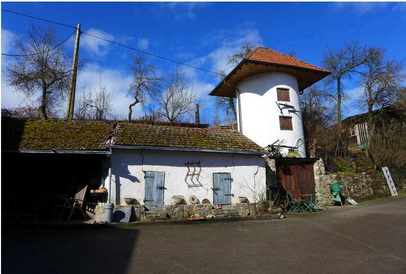
Altes Silo und alter Schweinestall des Füllenbacherhofes bei Seibersbach (2017) Fotograf/Urheber: Vivien Behrens
