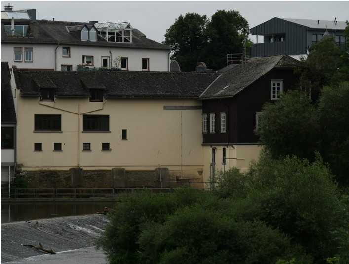
Nordansicht der Niedermühle Limburg mit Wehr (2017) Fotograf/Urheber: Jörn Schultheiß
