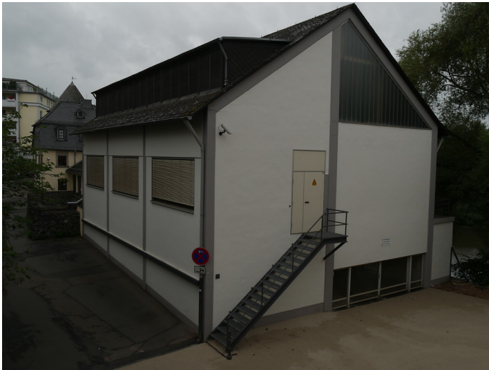
Modernes Betriebsgebäude im Bereich der Niedermühle Limburg (2017) Fotograf/Urheber: Jörn Schultheiß
