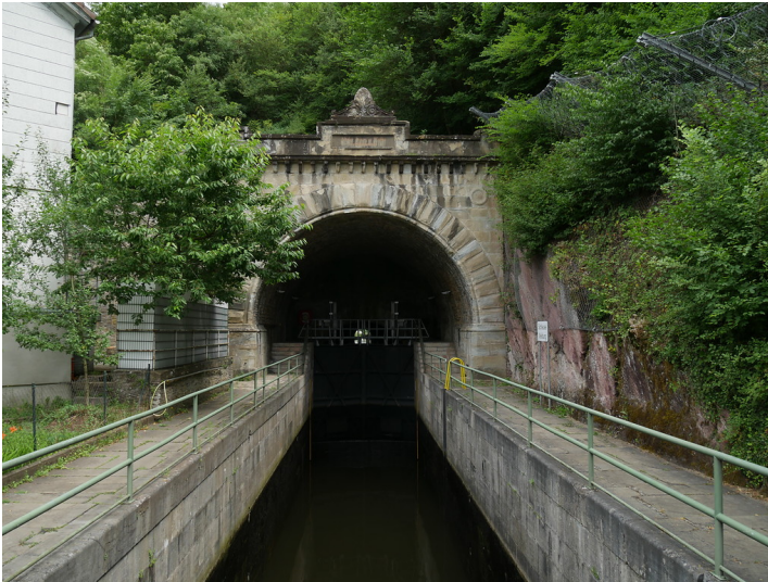
Am linken Bildrand ist das Tunnelhaus, in der Bildmitte die obere Kammer der Doppelschleuse Weilburg zu erkennen, die bis in den Schiffahrtstunnel reicht (2017) Fotograf/Urheber: Jörn Schultheiß
