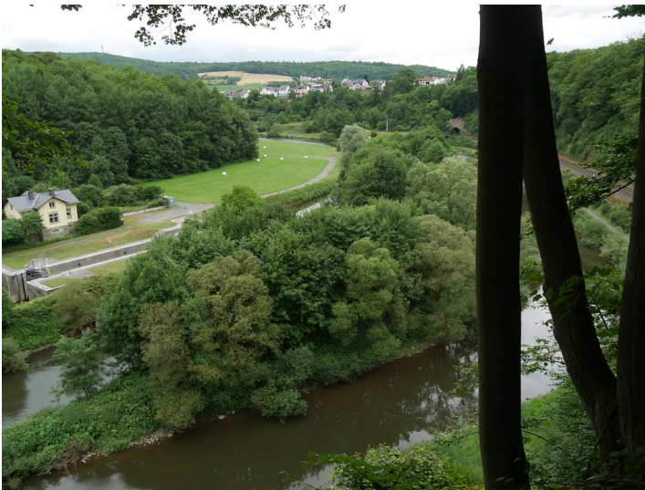
Schleuse Kirschhofen bei Weilburg mit Schleuseninsel (2017) Fotograf/Urheber: Jörn Schultheiß
