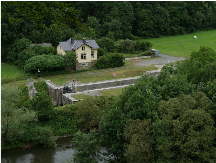
Schleuse Kirschhofen bei Weilburg (2017) Fotograf/Urheber: Jörn Schultheiß
