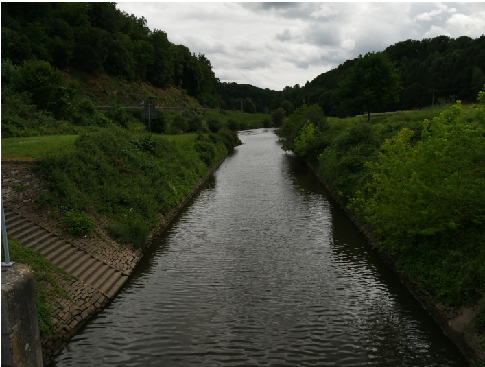
Schleusenkanal der Schleuse Fürfurt bei Villmar (2017) Fotograf/Urheber: Jörn Schultheiß
