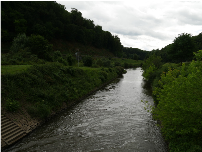
Unterer Kanal der Schleuse Fürgurt bei Villmar (2017) Fotograf/Urheber: Jörn Schultheiß
