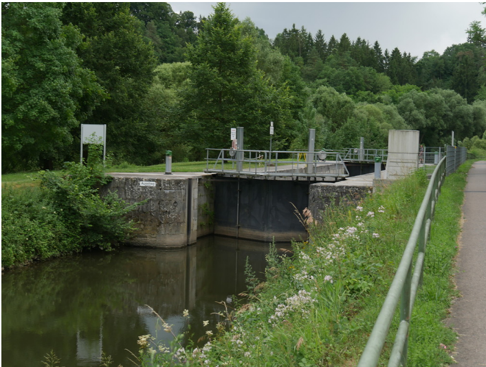
Kanal, Tor und Kammer der Schleuse Villmar sowie, in der linken Bildhälfte die Schleuseninsel (2017) Fotograf/Urheber: Jörn Schultheiß
