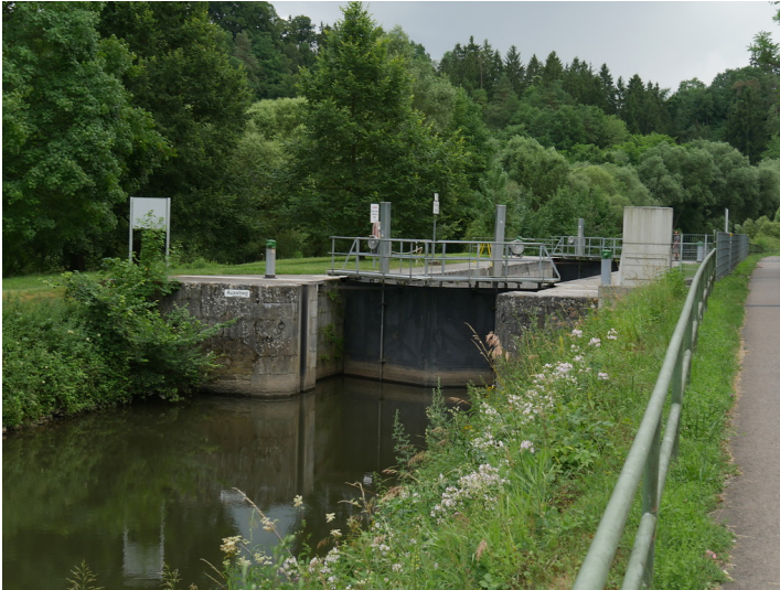
Kanal, Tor und Kammer der Schleuse Villmar sowie, in der linken Bildhälfte die Schleuseninsel (2017) Fotograf/Urheber: Jörn Schultheiß
