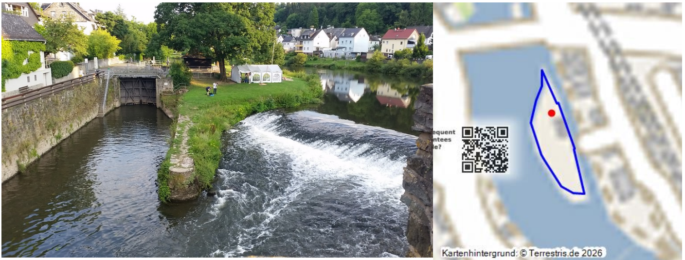
Kanal sowie nördliches Tor der Schleuse Runkel und Schleuseninsel (2017) Fotograf/Urheber: Stefanie Cole
