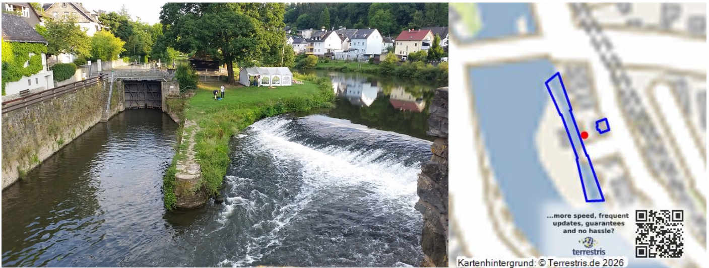
Kanal sowie nördliches Tor der Schleuse Runkel und Schleuseninsel (2017) Fotograf/Urheber: Stefanie Cole
