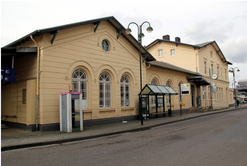
Empfangsgebäude des Bahnhofs Herzogenrath (2017) Fotograf/Urheber: Burggraaff, Peter
