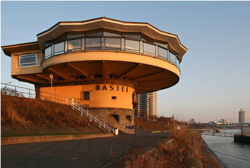
Blick auf die dem Rhein zugewandte Seite der Bastei am Kölner Konrad-Adenauer-Ufer (2008). Fotograf/Urheber: Superbass
