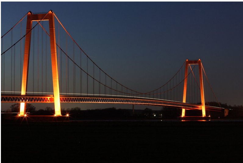
Abendliche Ansicht der Rheinbrücke Emmerich (2009); das Bild lässt erkennen, warum das Bauwerk auch "Golden Gate Bridge vom Niederrhein" genannt wird. Fotograf/Urheber: Maarten Takens
