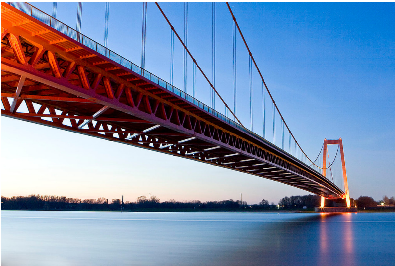
Ansicht der Rheinbrücke Emmerich (2009); das Bild lässt erkennen, warum das Bauwerk auch "Golden Gate Bridge vom Niederrhein" genannt wird. Fotograf/Urheber: Maarten Takens
