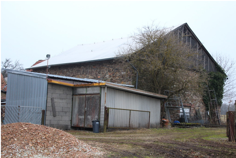
Gebäude der ehemaligen Ziegelhütte bei Seibersbach (2017) Fotograf/Urheber: Svenja Kind
