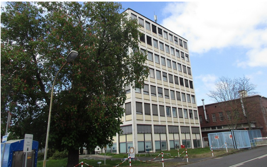
Verwaltungsgebäude am Fabrikgelände der früheren Dynamit Nobel AG in Troisdorf (2017). Fotograf/Urheber: Franz-Josef Knöchel
