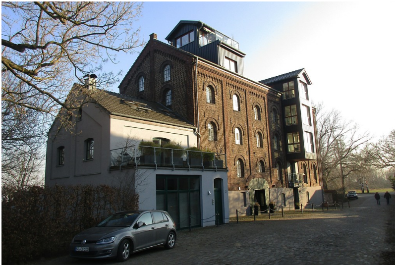
Gebäude der Eschmarer Mühle bei Troisdorf-Eschmar (2017). Fotograf/Urheber: Franz-Josef Knöchel
