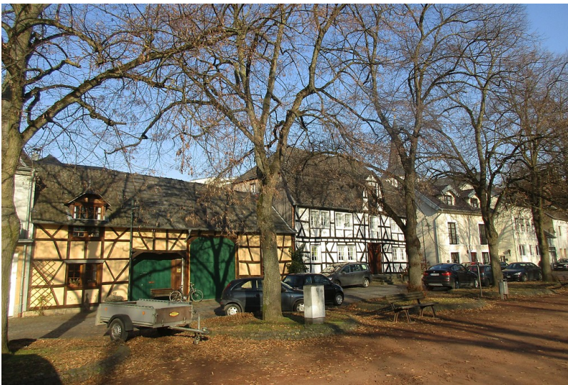
Fachwerkgebäude am Marktplatz in Troisdorf-Sieglar (2017). Fotograf/Urheber: Franz-Josef Knöchel
